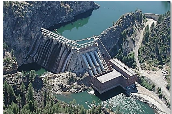
Long Lake Dam & Spillway
